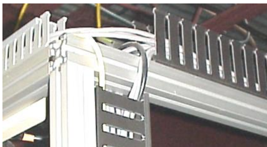
Abb. 22: Kabelkanäle
