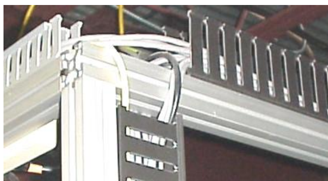
Abb. 24: Kabelkanäle
